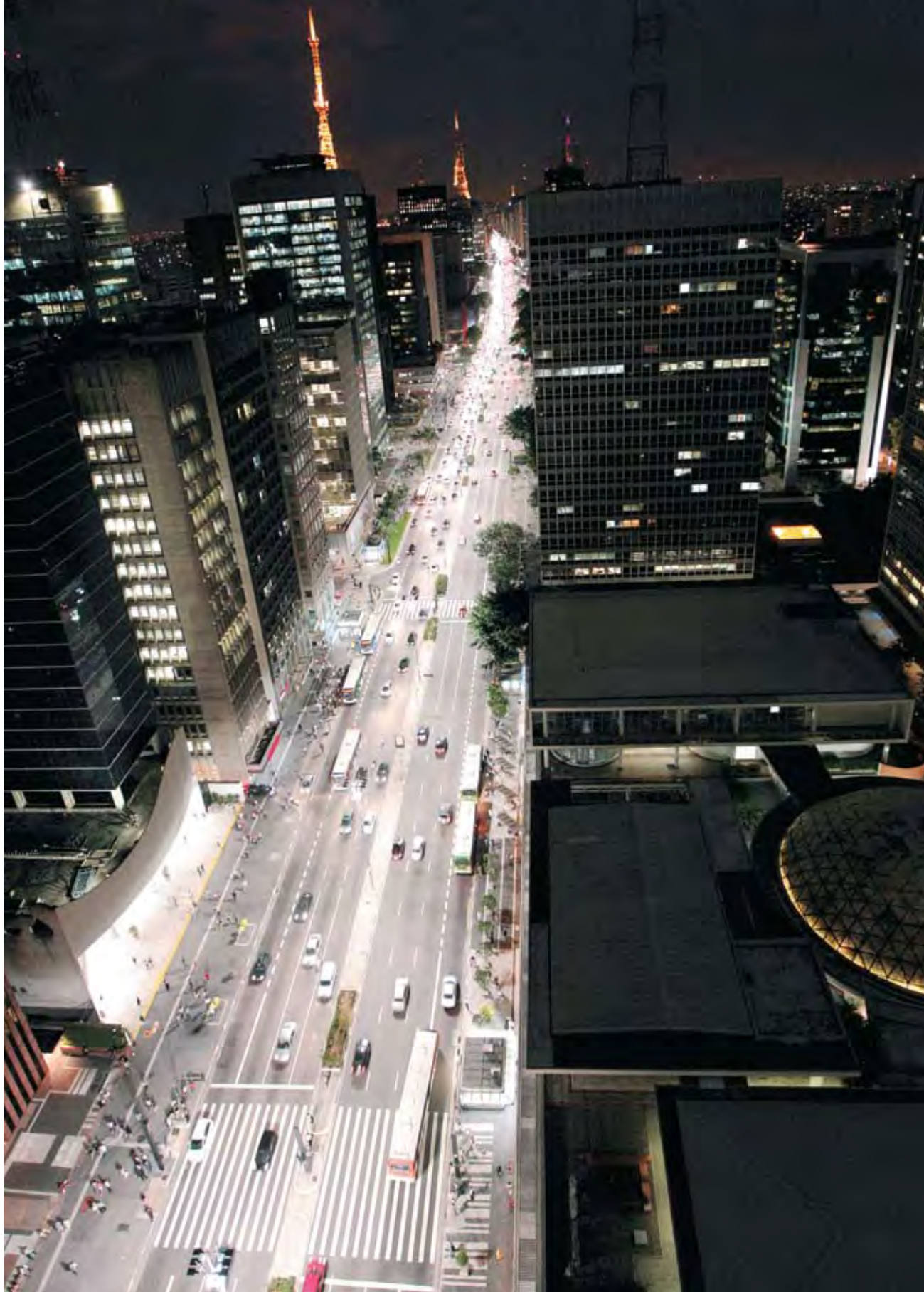
Avenida Paulista com nova iluminação LED, instalada no início de 2011: a meta é trocar 260 mil lâmpadas na cidade
