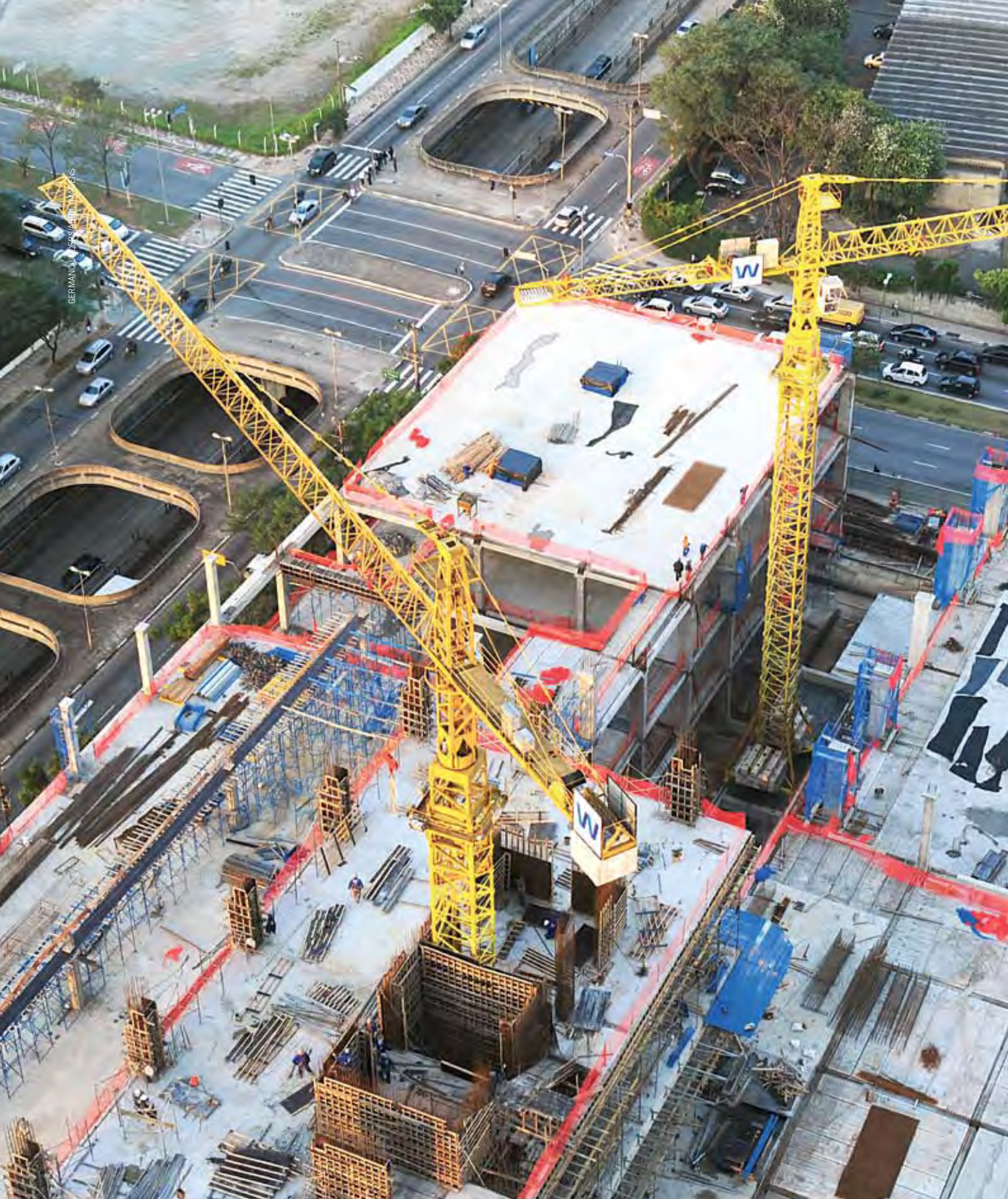
Obra do novo Shopping Vila Olímpia, zona sul: São Paulo tem mais de 50 grandes centros de consumo pela cidade
