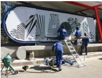
Trabalhos de arte com jato de areia na entrada das estações BRT
