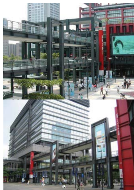
O sistema de rotas elevadas do novo distrito de Xinyi (Charles Lin)
