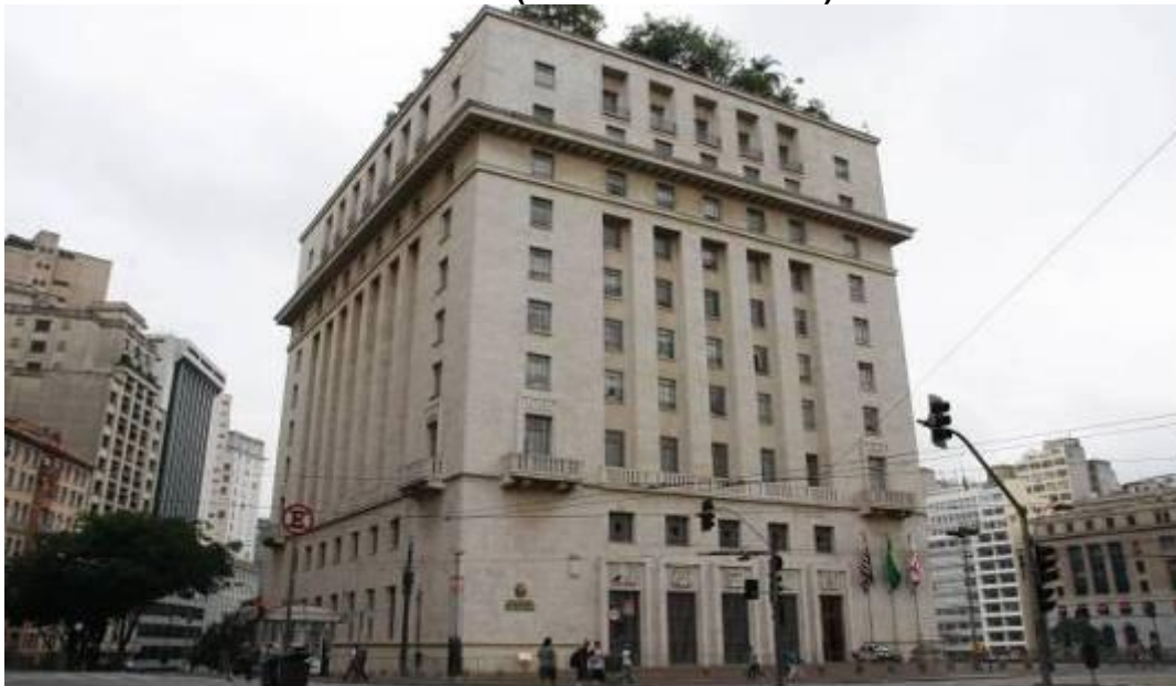
Imagem do local – Face Viaduto do Chá
