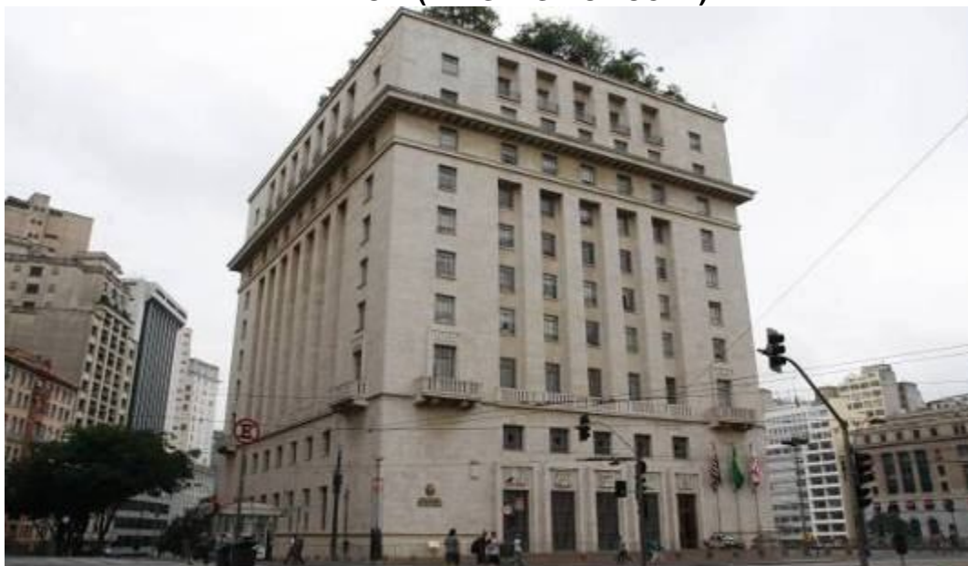
Imagem do local – Face Viaduto do Chá
