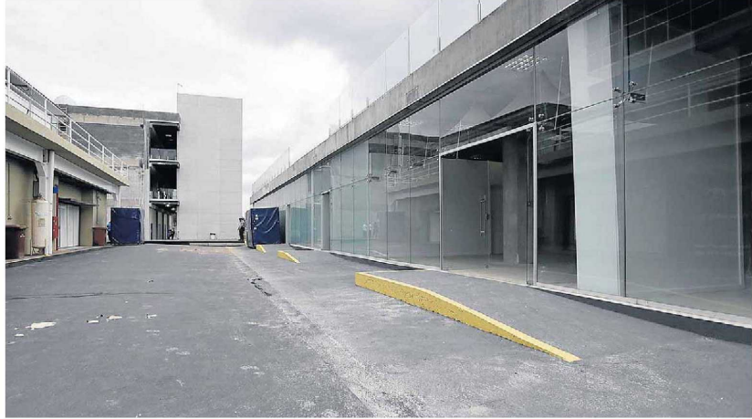
Revitalização A área do paddock de Interlagos finalmente teve a reforma concluída e ficou mais espaçosa e prática
